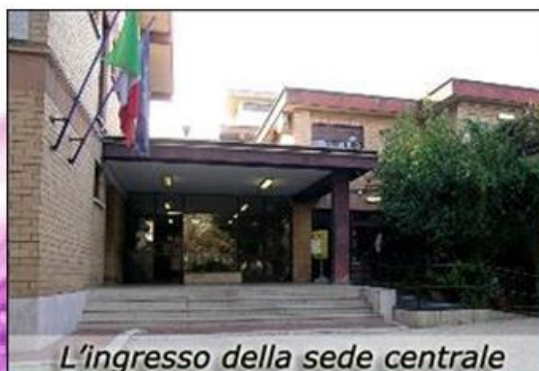
Scuola Secondaria di I grado "Via T. Mommsen, 20" Largo Tacchi Venturi, 5
